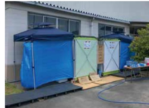
左上) 背中あわせにENCOURAGE II型を2セット、合計4室のシャワーを設置。背中合わせにすることで排水経路をシンプルに設置。
